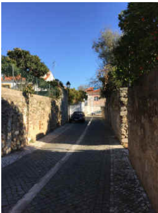
Figura 27. Muros de suporte de terras confinantes com a via pública
