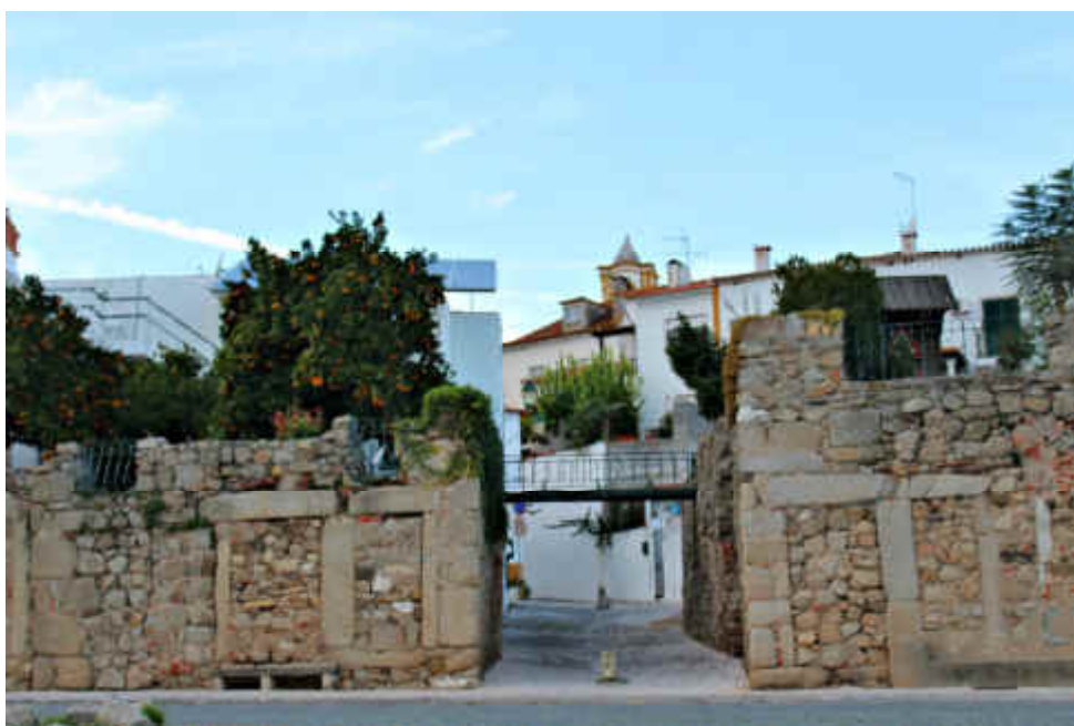
Figura 13. Antigos armazéns do cais de Tancos
