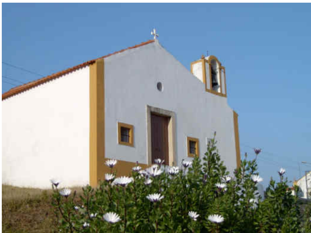
Figura 8. Capela de Nossa Senhora da Piedade
