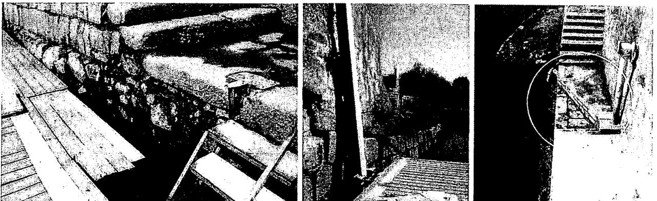
Fig. 9 – Aspetos dissonantes e patologias visíveis: assentamentos, fracturações, abertura de juntas e matérias dissonantes (patim inferior da escada nascente).
