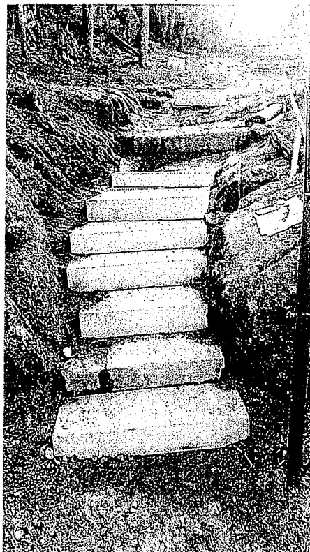
Foto 3: Colocação de degraus
